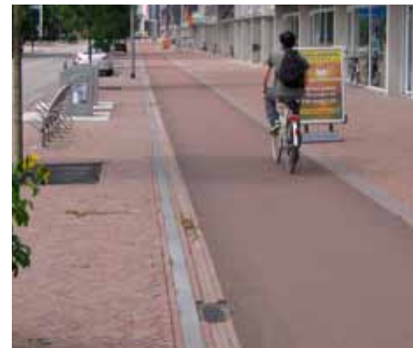
fietspaden in samenhang (asfalt)
